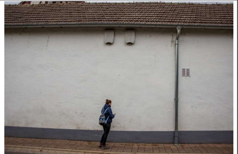
FL5 und FL6 an der Außenmauer des Gutshofs
